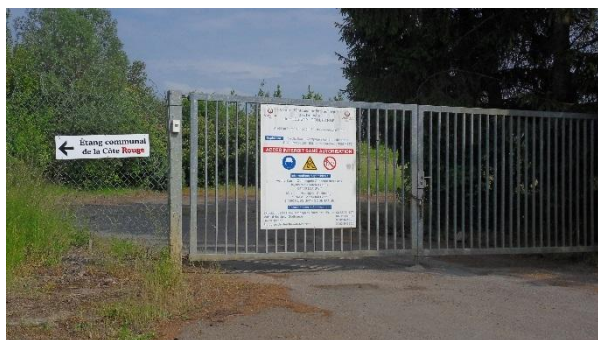
Centre d'Enfouissement Technique des déchets.
