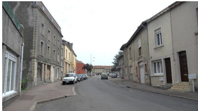
Alignement bâti, rue du Maréchal Foch.
